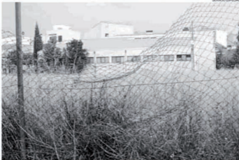
Valle rota en uno de los solares abandonados de Valdeferro, barrio con más de cien espacios de este tipo.
